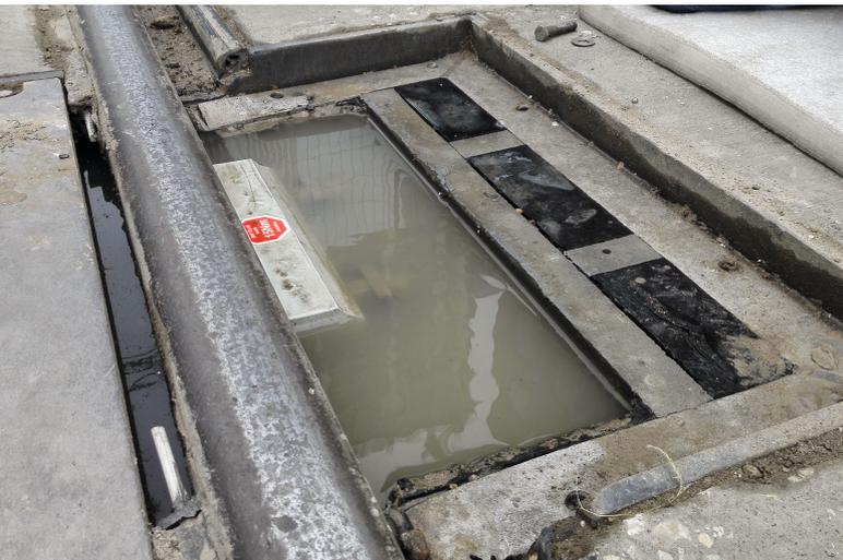
**Bild 2: Selbst unter Wasser müssen induktive Radsensoren höchst zuverlässig funktionieren.**
