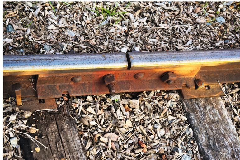
**Bild 3: Schocks an Schienenstößen stellen Herausforderungen für Sensoren und Montagevorrichtungen dar.**
